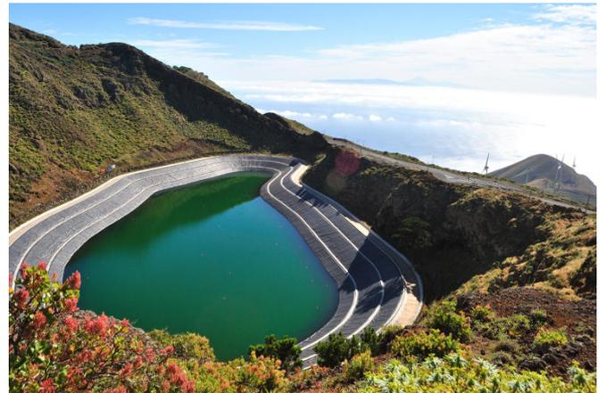
Dès que le vent faiblit ou s'arrête, les éoliennes ne produisent plus d'électricité. Alors l'eau stockée est relâchée et se déverse dans un bassin inférieur grâce à des conduites forcées, ce qui met en marche une centrale hydroélectrique qui produit donc à la demande de l'énergie électrique.
